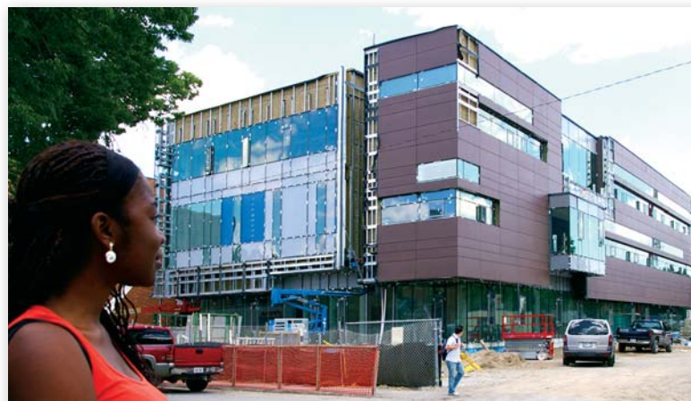
Ogheneruemuse (Christy) Ekpekurede, étudiante en génie civil, examine de près la construction du nouvel immeuble destiné à la formation médicale à l'Université de Windsor.
